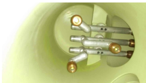
图 5 电缆气室处理完后内部情况的照片
