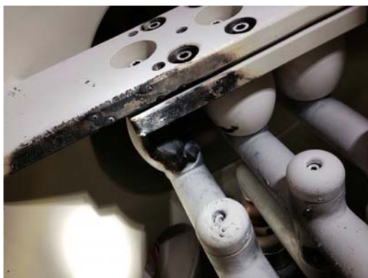
图 6 管形母线的支持瓷瓶
