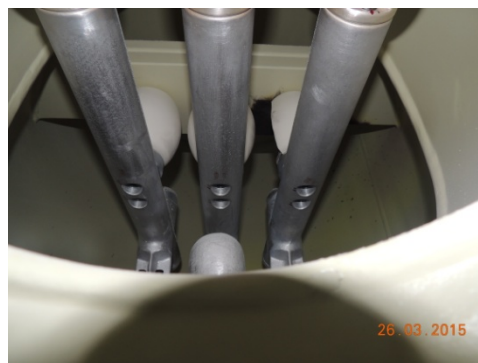
图 2 A 相瓷瓶表面有贯穿性的放电痕迹
