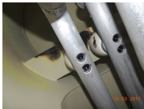
图 3 A 相支持瓷瓶底部的铸铁板上有明显的放电痕
